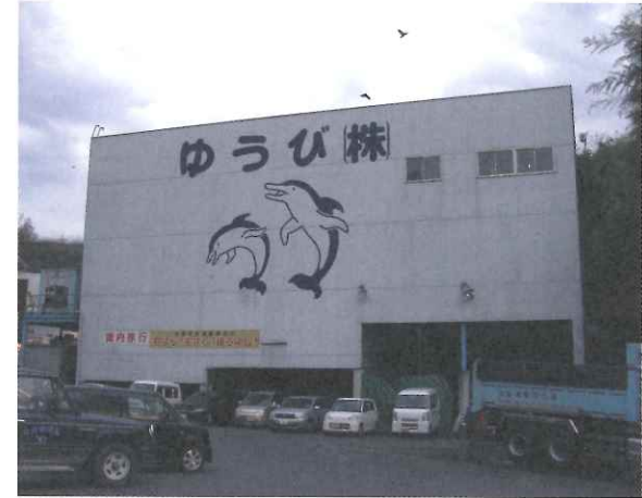
選別工場棟の外観
