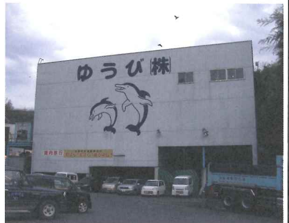
選別工場棟の外観
